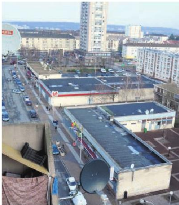
CREIL, QUARTIER HENRI-DUNANT. Le feu vert a été donné pour la démolition partielle du centre commercial Henri-Dunant moyennant de nouvelles expertises avant l'expropriation des commerçants.
